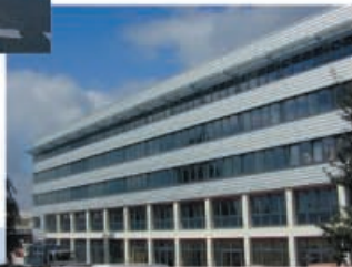
Flughafen Gebäude 245 Hamburg Fuhlsbüttel
