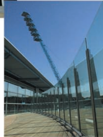
Ostseestadion VIP Dachterasse West Rostock
