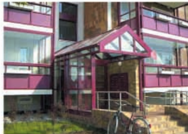
WIRO – Mietshaus Rostock
