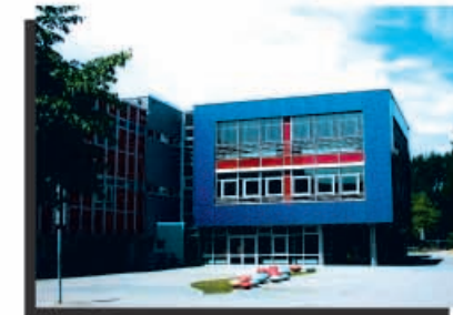
Glasfassade Berufsschule Ahrensburg
