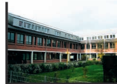
Dachgeschoss Fensterelemente; Lichtdächer Gymnasium Trittau
