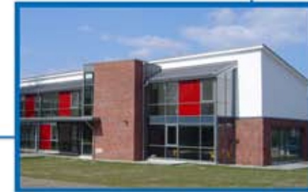
Gymnasium Am Markt Achim
